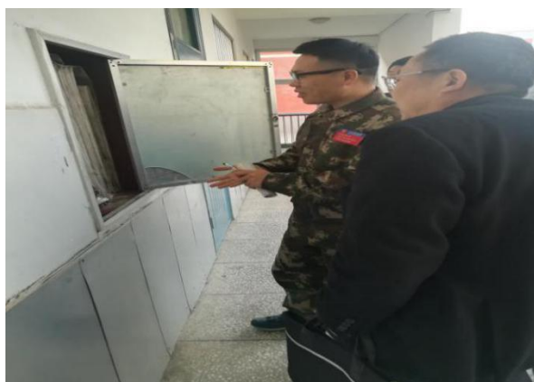
专家组在晋城城区凤鸣小学查看消防设备
